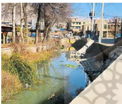
شکل ۵: ریزش دیواره‌های اطراف چشمه برم نزدیک به سازه سنگین فلزی مصلا امام خمینی (ره) لردگان
