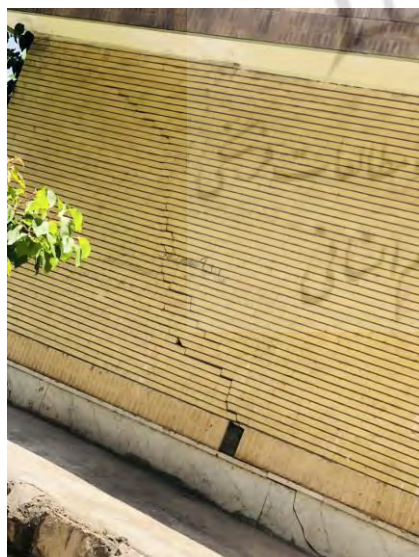
شکل ۶: ترک در سازه‌های نزدیک به چشمه و در محدوده مرکز شهرستان، مرکز کانون پرورش فکری کودکان
