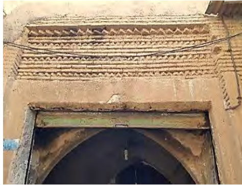
تصویر شماره ۹- استفاده از آجر و کاهگل در نمای بیرونی حجره - بازار دزفول. منبع: یافته‌های تحقیق، ۱۴۰۰
