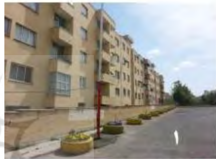
مجموعه مسکونی امیرکبیر
