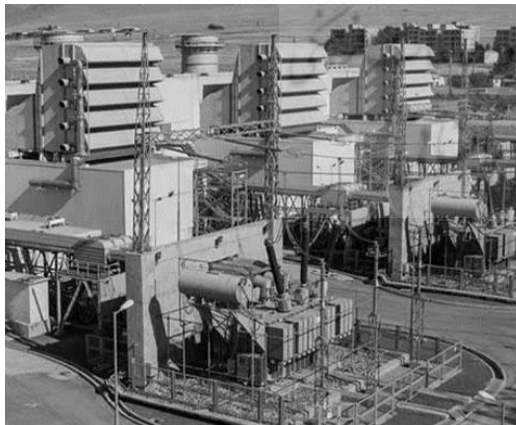
تصویر ۵: جداسازی کالبدی ترانسفورماتورها از دیگر بخش‌های همجوار با فنس و دیوار بتنی؛ مأخذ: نگارنده
