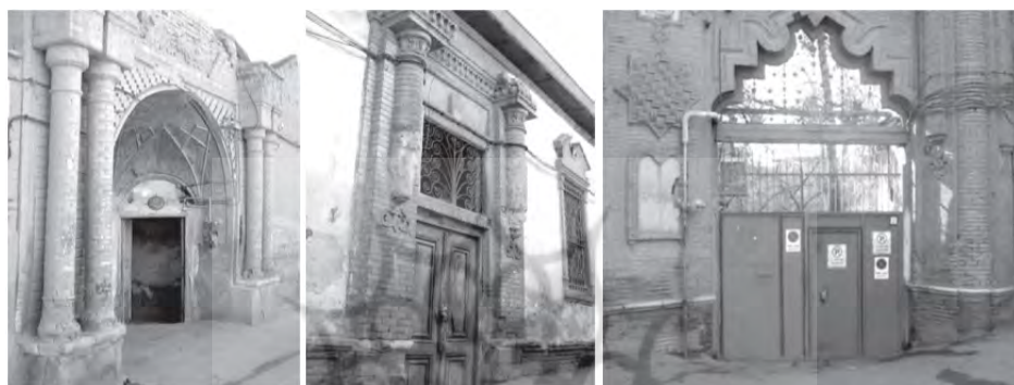
تصویر ۶. ارتفاع و تزیین سردر خانه‌های قاجاری تهران؛ راست: خانه اتحادیه در محله دولت؛ وسط: خانه‌ای در محله چال میدان؛ چپ: خانه‌ای در محله سنگلج (منبع: رمضان‌جماعت و نیستانی، ۱۳۸۹: ۶۹ و ۷۱)
