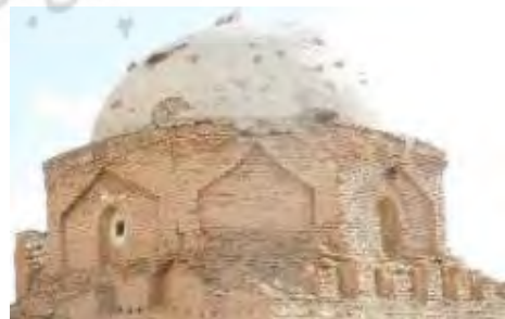
تصویر ۴۸: آجرکاری دور چپیره آرامگاه میرمطهر.
