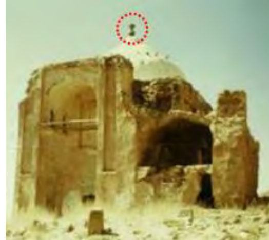
تصویر ۱۹: توغ گنبد آرامگاه باباتوکل. ماخذ: گزارش ثبتی اثر، ۱۳۸۲.
