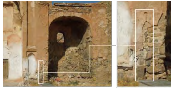
تصویر ۳۰: عدم اتصال دو بخش و الحاقی بودن ایوان کوچک آرامگاه باباتوکل.
