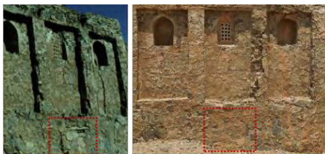
قبل از مرمت و مشخص بودن نعل درگاه بازشو / بعد از مرمت و پوشاندن محل بازشو با ملات
