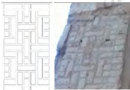
تصویر ۴۹: تزئینات آجری ایوان ورودی آرامگاه میرمطهر.
