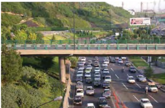
عکس ۲. توجه به تفاوت دو نوع بدنه سازی در تعدیل شیب بدنه‌ها برای تثبیت خاک و درعین حال انطباق هر چه بیشتر با فراز و نشیب زمین قابل ملاحظه است؛ مأخذ: غلامرضا پاسبان حضرت، ۱۳۸۹
