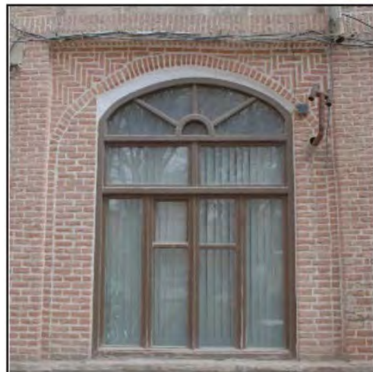
تصویر ۴. اجرای غلط چفد کلیل، سرای حاج حسین میانه (ماخذ: نگارندگان)
