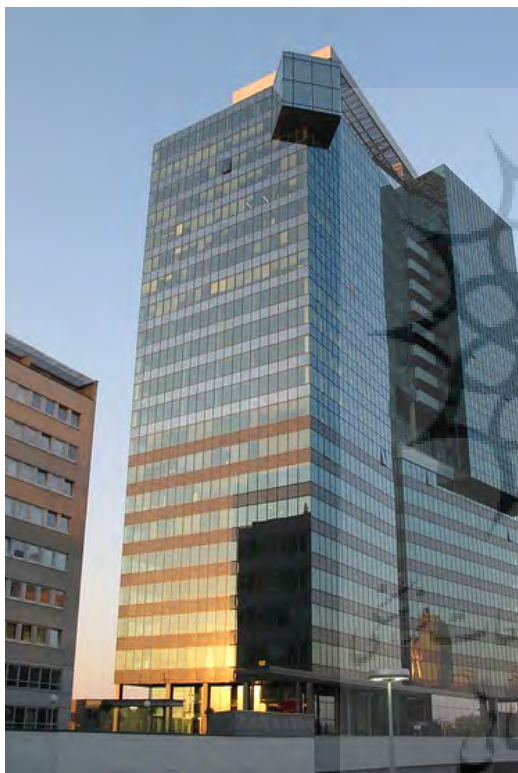
شکل ۱. برج رسانه ای، هانس هولاین؛ منبع: کتاب مقدماتی بر روشهای طراحی. کاوه بذرافکن
