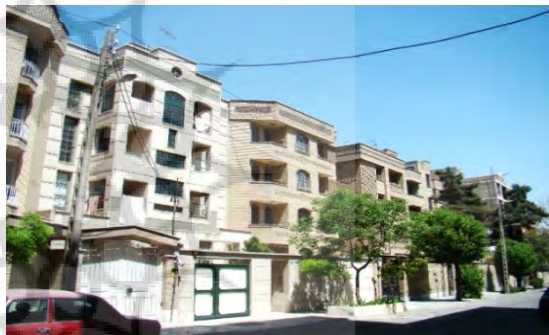
تصویر ۴. بالکن‌های اجرا شده در پخ ۴۵ درجه
