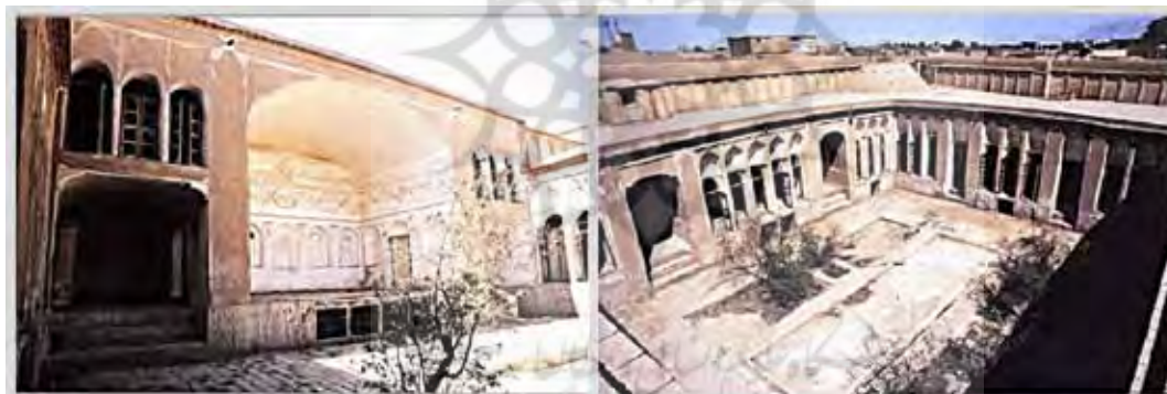
شکل ۱. تصاویری از نماهای داخلی خانه مشکیان (یزد). تصویر راست: جبهه‌های شمال شرقی و شمال غربی حیاط؛ مأخذ: حاجی قاسمی، ۱۳۸۳، ص ۲۰۲؛ و تصویر چپ: جبهه جنوبی حیاط و ایوان مرکزی آن؛ مأخذ: حاجی قاسمی، ۱۳۸۳، ص ۲۰۱.
