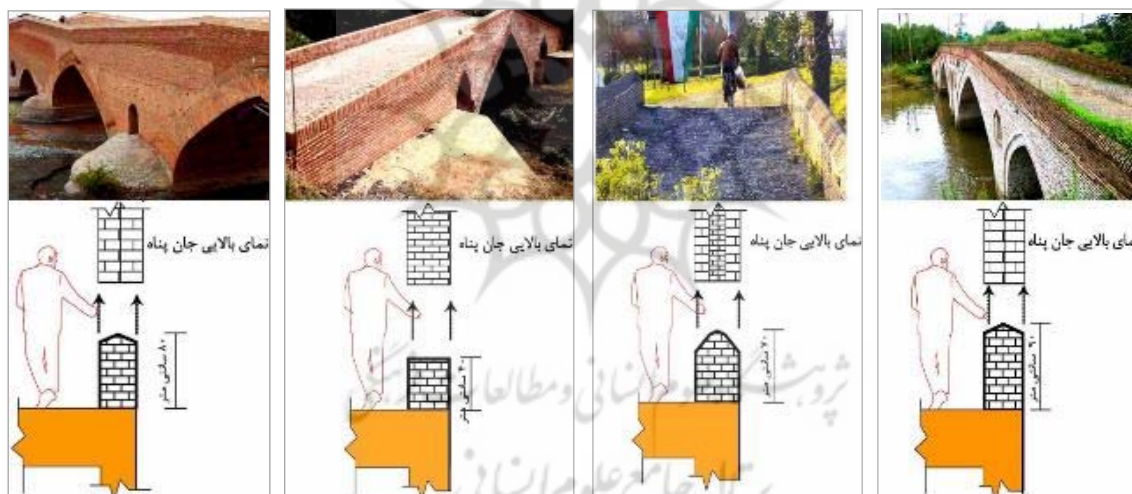
تصویر ۳۵. جان‌پناه پل تمیجان (صفویه) تصویر ۳۶. جان‌پناه پل گازروبار (قاجاریه) تصویر ۳۷. جان‌پناه پل گوراب تولم (قاجاریه) تصویر ۳۸. جان‌پناه پل لوشان (قاجاریه) (همان) (همان) (همان) (نگارندگان، ۱۴۰۰)
