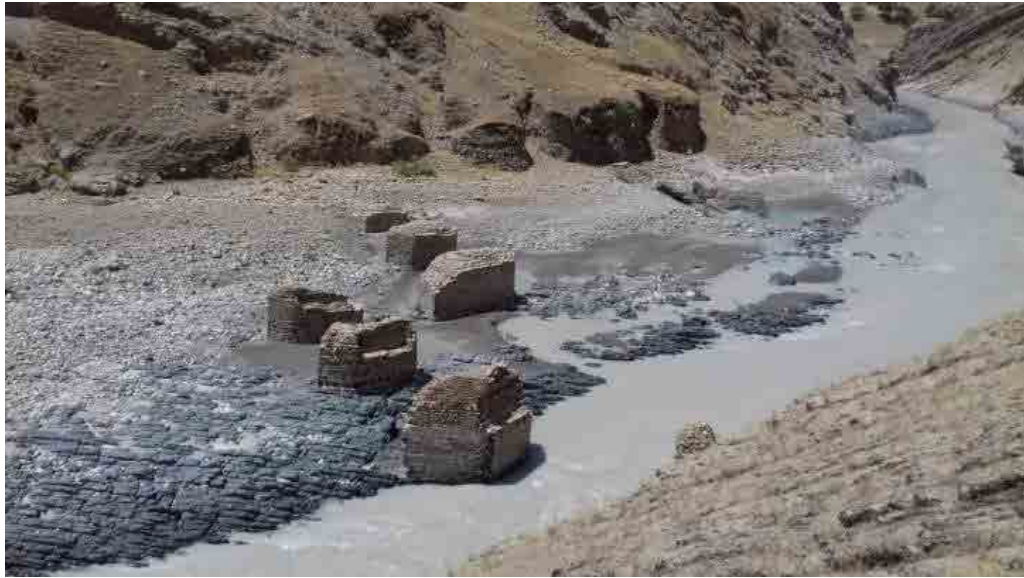
تصویر ۳. نمای از پل شماره ۱ نوم کول. دید از شرق (نگارنده، ۱۳۹۸).
