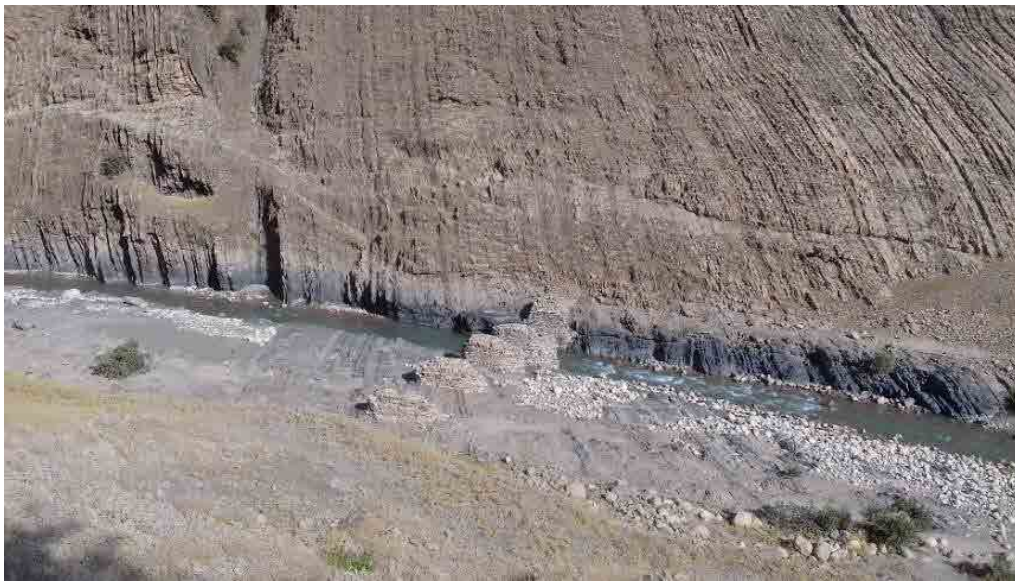
تصویر ۱۱. دورنمای پل شماره ۳ نومکول. دید از شرق (نگارنده، ۱۳۹۸).
