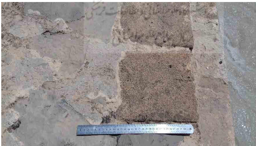
تصویر ۵. آجرهای به کار رفته در پا کار قوس تاق‌های پل شماره ۱ نومکول (نگارنده، ۱۳۹۸).
