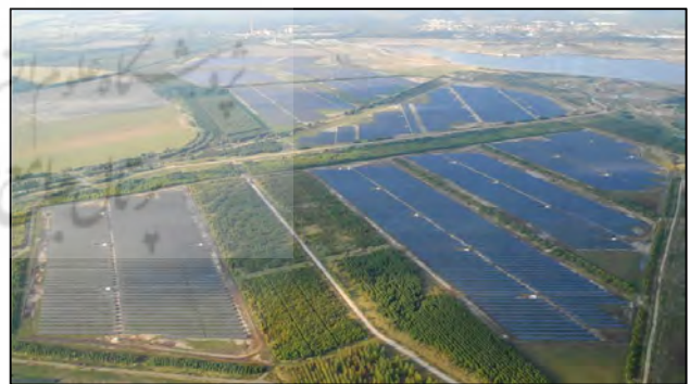
شکل 30: نیروگاه 166 مگاواتی موبرو در آلمان
