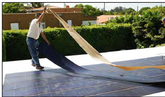
شکل 7: آرایه خورشیدی لایه نازک و انعطاف پذیر سیلیکون آمورف در حال پهن شدن روی پشت بام
