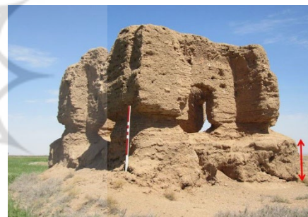
شکل ۹. نحوه سکوسازی آرامگاه دستگردان، ضلع جنوبی بنا (Authors, 2018)
