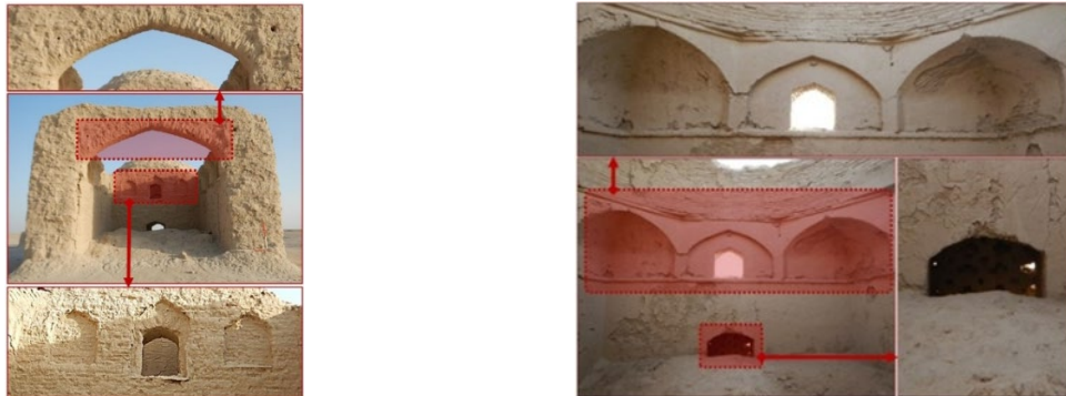
شکل ۶. رگه‌چینی اطراف طاق‌ها و طاقچه‌ها در آرامگاه ۲ (چپ)، اندود گچ در اطراف طاق‌ها و رگه‌چینی اطراف زیر گنبد در آرامگاه ۴ (راست) (منبع: Authors, 2023)
