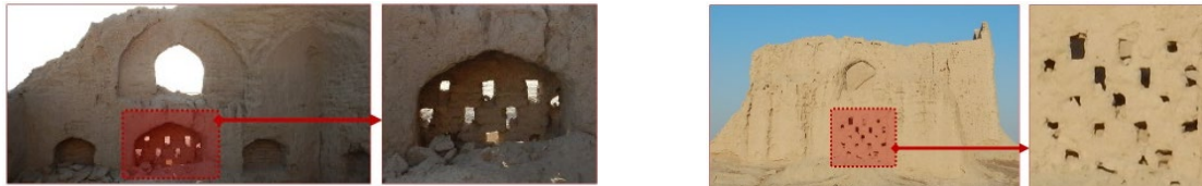
شکل ۱۰. پنجره‌های مشبک ورود نور و روزنه زیر گنبد در آرامگاه ۸، از فضای داخل (چپ) و از بیرون (راست) (منبع: Authors, 2023)
