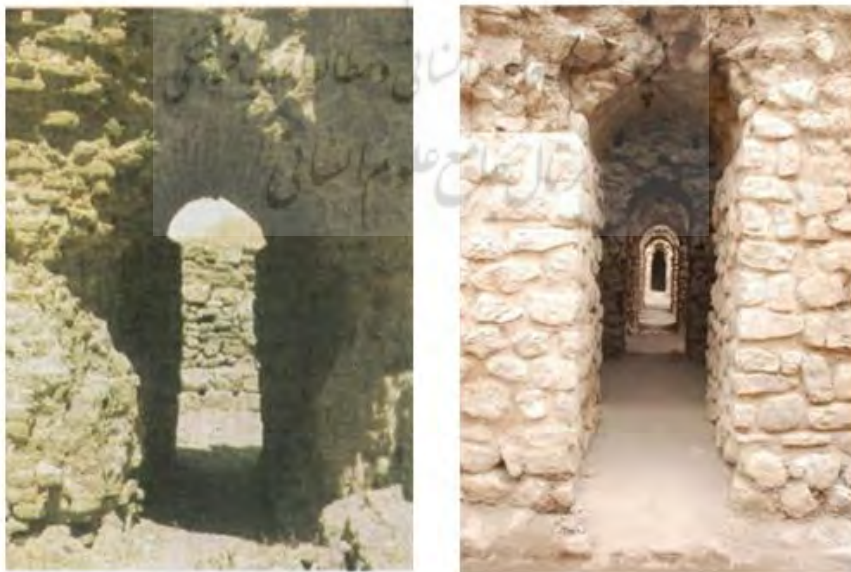
شکل ۱۰: ویژگی معماری سوراخ کلیدی ساسانی در بنای زیج منیژه، سمت راست (آرشیو میراث فرهنگی کرمانشاه، ۱۳۹۲) و تخت سلیمان، سمت چپ (هرمان، ۱۳۷۳:۱۳۰)
