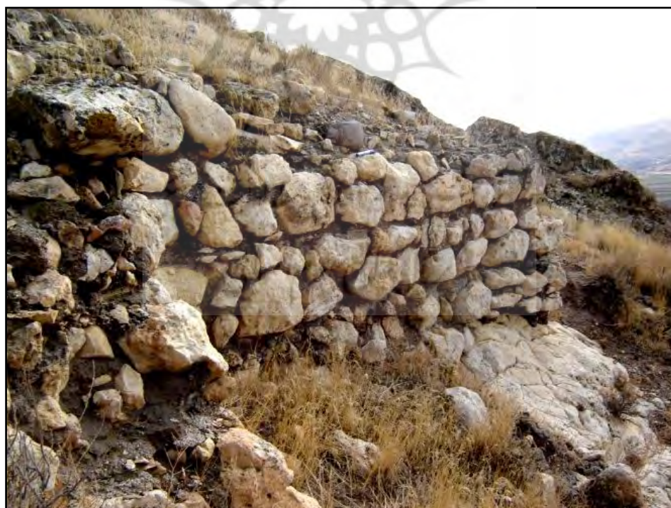
تصویر ۱۳: دیوار باقیمانده از معماری سنگی قلعه با ملات ساروج در سطح بالای تپه آق قلعه
