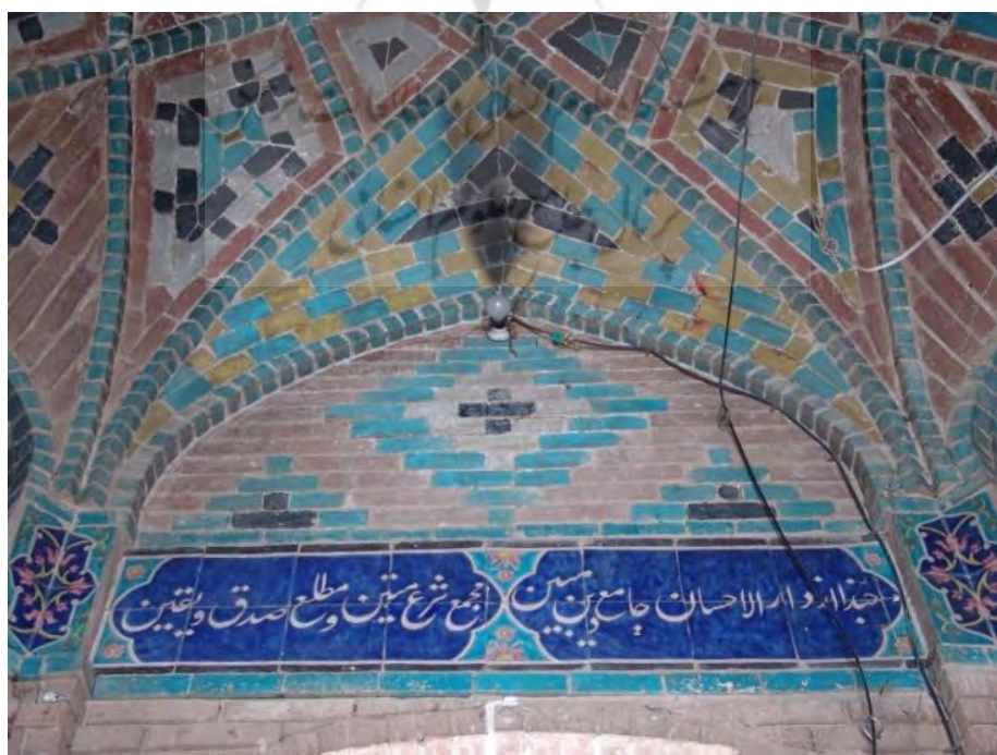
تصویر ۲۰: نمای داخل هشتی ورودی مسجد - مدرسه (عکس از نگارنده، ۱۳۸۵).
