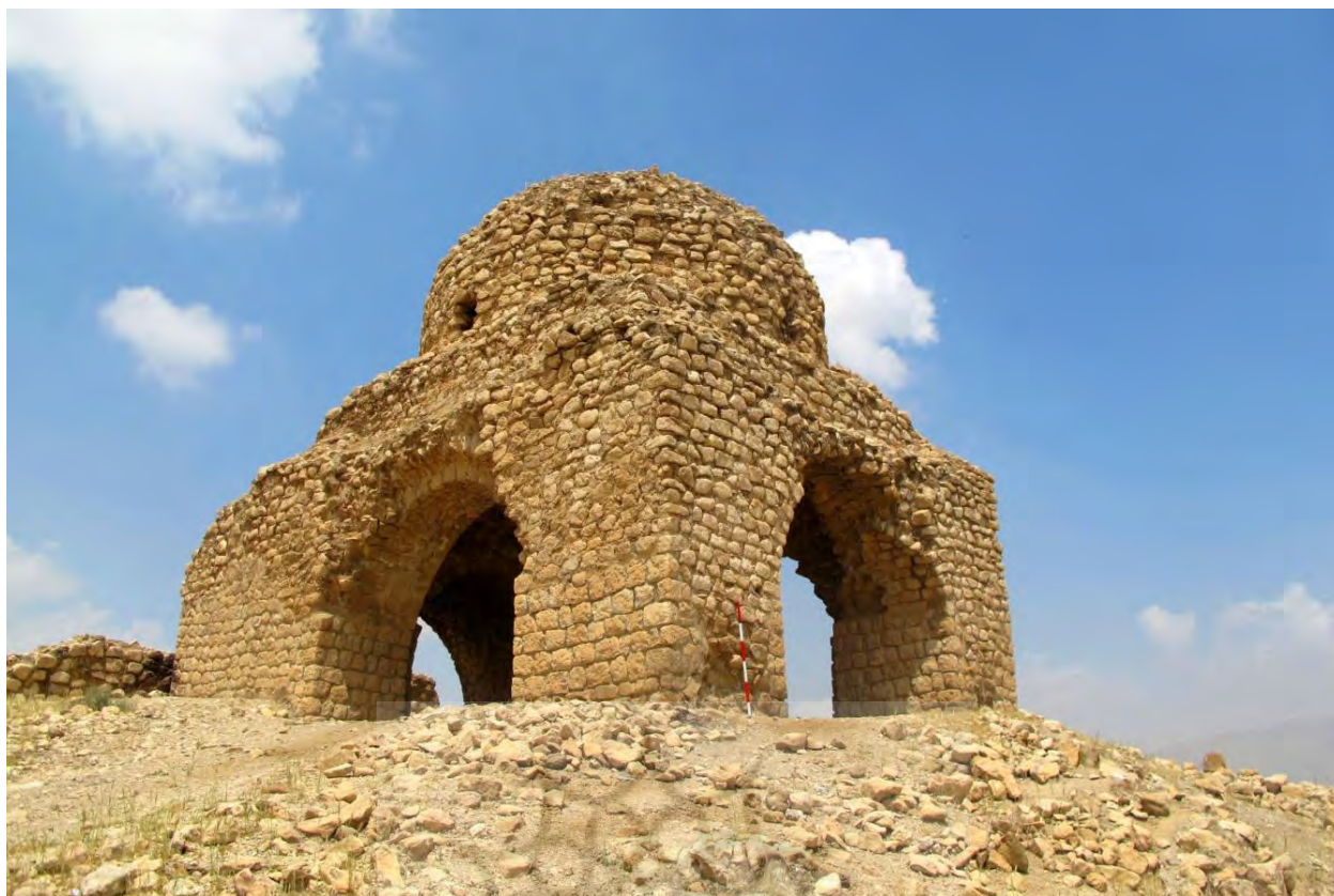
تصویر ۴: طبقه چهارم و چهارطاقی از سمت جنوب شرقی (عکس از نگارندگان).
