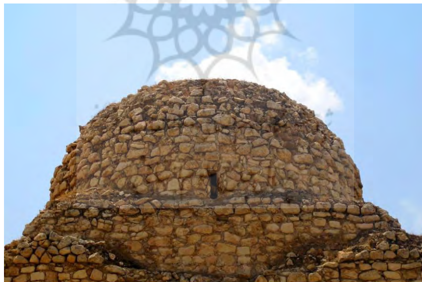
تصویر ۱۴: زیر گنبد چهارطاقی، مرمت شده با مخلوط سیمان و آب (عکس از نگارندگان).
