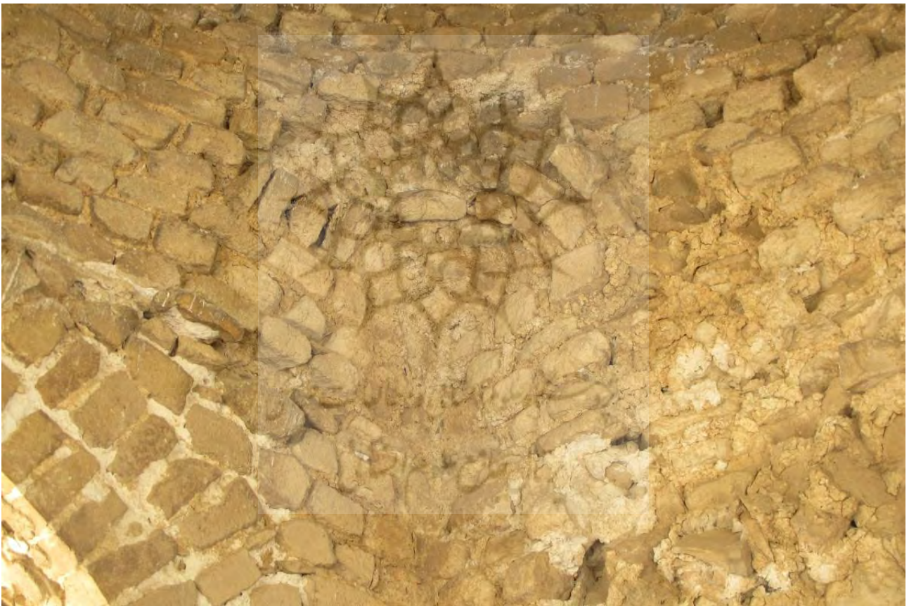
تصویر ۱۳: وضعیت فیله‌پوش مرمت شده در زیر گنبد (عکس از نگارندگان).
