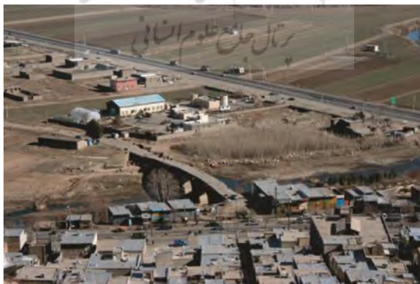
تصویر ۲۴: منظره عمومی پل بیستون (دید از غرب) (خان‌مرادی، ۱۳۸۷: ۱۵۷، تصویر ۱۵).
