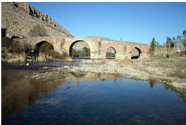
تصویر ۲۵: نمای جنوبی پل بیستون (بایگانی مرکز اسناد پایگاه میراث فرهنگی بیستون).
