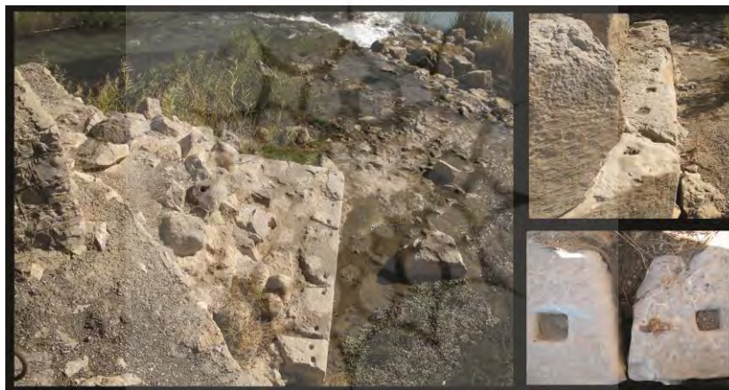
تصویر ۲۳: آبشکن‌های مثلثی و بستهای فلزی به کار رفته در ساختار پایه‌های پل خسرو (عکس‌ها از: مژگان خان‌مرادی).
