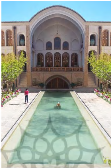
شکل ۶. خانه منوچهری - ساخت حوض بزرگ و کم عمق برای بالا بردن رطوبت در حیاط مرکزی
