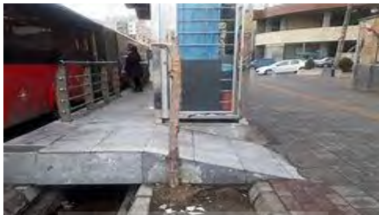
عکس ۳. احداث رمپ در سکوی ایستگاه منبع: (بازدید میدانی نگارندگان، ۱۴۰۱)
