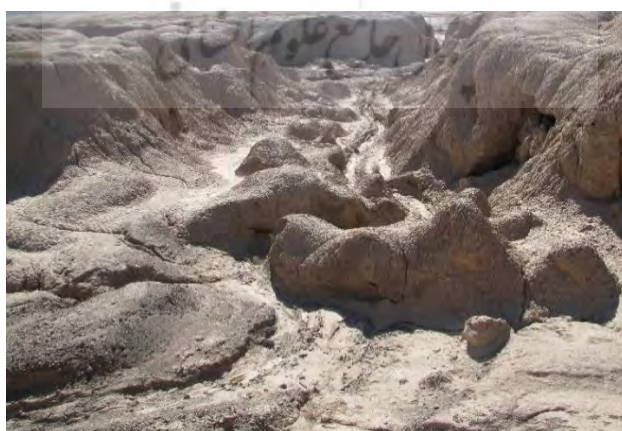
شکل ۱۲: تصویر نمونه ای از یک آبکند ریزشی حاصل از ریزش سقف یک رگاب افقی بزرگ
