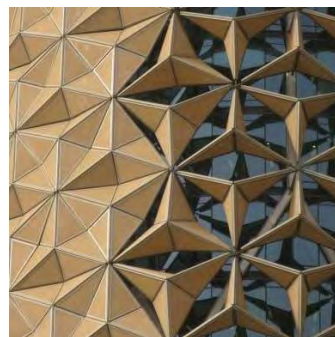
تصویر ۱۱. نمایی از برج‌های البحر ابوظبی، بخشی از پوسته نمای برج و واحد طراحی پوسته آن (خبازی، ۱۳۹۰: ۲۲).
