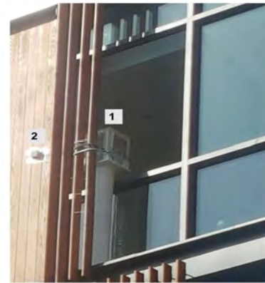
تصویر ۱- موقعیت قرارگیری دستگاه دیتالاگر در مجاورت نمای خارجی، ۱- دستگاه اصلی در داخل یک محفظه با قابلیت تهویه قرار گرفته است و دمای هوا و رطوبت نسبی محیط بیرون را ثبت می‌کند؛ ۲- سیم ترموکوپل دستگاه در داخل یک محفظه بر روی نمای بیرون نصب شده و دمای سطح خارجی دیوار را ثبت می‌کند.
