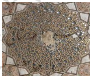
تصویر ۲. کپبری، سقف اتاق عمارت هشت‌بهشت. منبع: نگارندگان.
