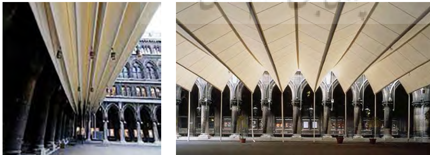
تصویر ۳: نمونه سقف باز و بسته‌شونده با مکانیزم غشایی، راست: پوشش سقف تالار شهر وین در حالت بسته، چپ: سقف این مجموعه در حالت باز (URL 1)
