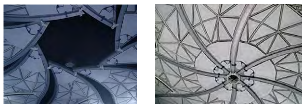
تصویر ۱۰: نمونه سقف باز و بسته‌شونده با مکانیزم قیچی‌سان، راست: سقف مرکز تنیس چیژانگ در حالت بسته، چپ: سقف این مجموعه در حالت باز (URL 4)
