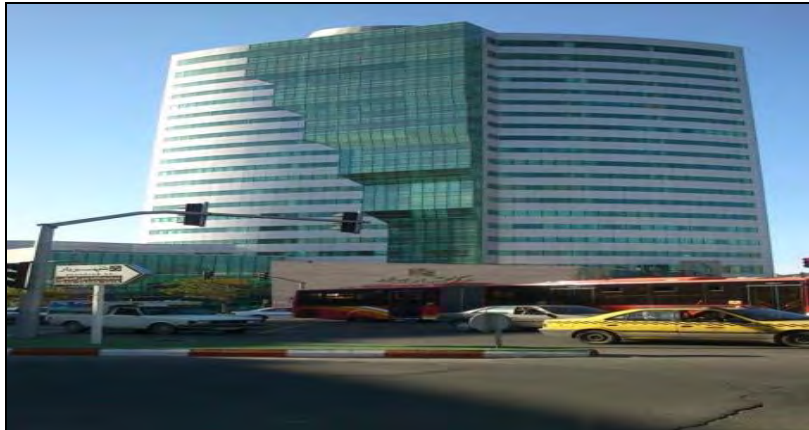
شکل ۴. استفاده از نمای شیشه‌ای در ساختمان بلند و مراکز پر تراکم (تبریز، میدان جانبازان)
