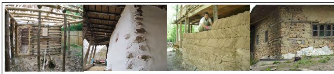
شکل ۱۰. انواع دیوار از راست به چپ: دیوار سنگی، دیوار خشتی، دیوار زگمه‌ای، دیوار زگالی
