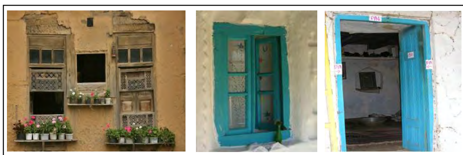
شکل ۷. درب ها و پنجره‌ها با اتصالات ساده و قابل واسازی (Source: Rural Architectural Heritage of Guilan)
