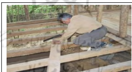
شکل ۹. کف سازی طبقات (Source: Rural Architectural Heritage of Guilan)
