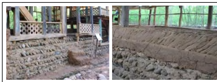
شکل ۳. نمونه کرسی چینی سنگی با ملات
