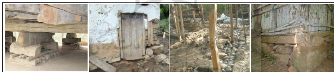
شکل ۲. انواع پی از راست: پی سنگی، پی اسکت چاه، پی سنگ زیر سری، پی شیکیلی
