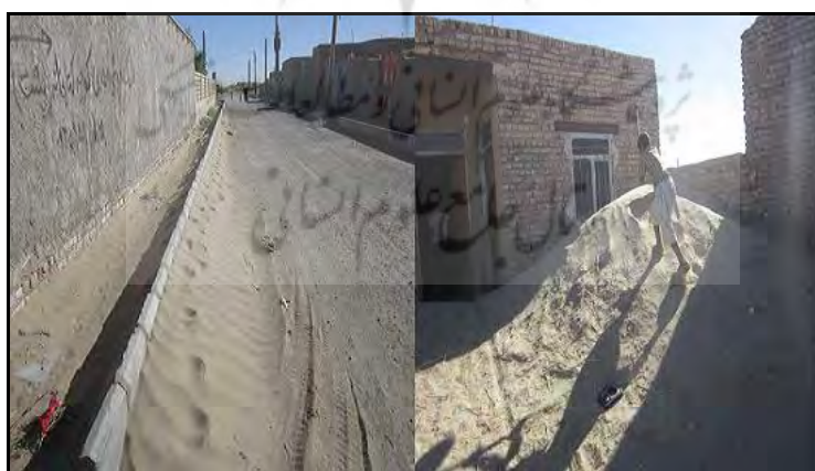
شکل ۶. وضعیت نامطلوب فضای کالبدی شهرک علی اکبر
