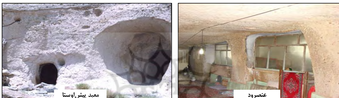
شکل ۱۰. تفاوت اندازه ذرات تشکیل‌دهنده سنگ، تفاوت کیفیت ساخت در مسجد جامع عنصرود و معبد پیش‌اوستا سبب شده است.
