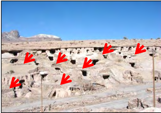
شکل ۱۲. گستردگی استفاده از سنگ‌چین‌ها برای ایجاد سطوح افقی در میمند
