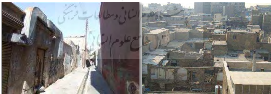
شکل ۷. کم دوامی بلوک‌های فرسوده در منطقه ۱۲
