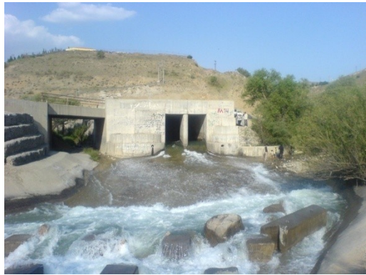
تصویر ۱- انحراف قسمتی از آب حوضه سد لار به سمت حوضه سد
