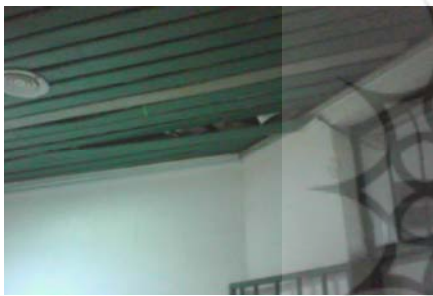
شکل ۲: تخریب سقف کاذب و فرو ریختن آب
