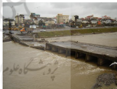
شکل (۱) سیلابی شدن رودخانه چشمه کیله و تخریب پل جانبازان (مهر ۱۳۹۴) شکل (۲) تخریب خیابان زیرگذر پل چشمه کیله واقع در مرکز شهر تنکابن (مهر ۱۳۹۷)
