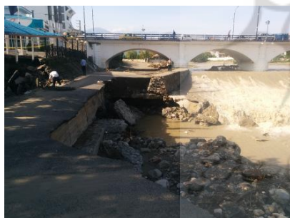
شکل (۱) سیلابی شدن رودخانه چشمه کیله و تخریب پل جانبازان (مهر ۱۳۹۴) شکل (۲) تخریب خیابان زیرگذر پل چشمه کیله واقع در مرکز شهر تنکابن (مهر ۱۳۹۷)
