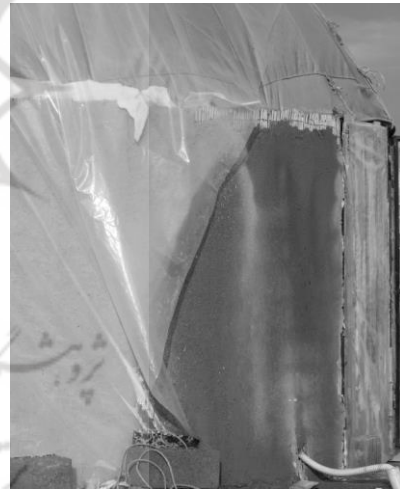
ت ۴. استفاده از اندود کاهگل جهت افزایش مقاومت
