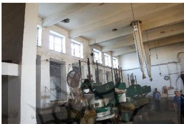
شکل ۱۱: طبقه هم‌کف کارخانه چای شعیب کلایه
