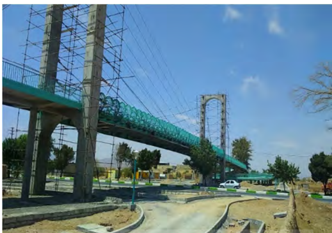
شکل ۴: پل زندگی که ارتباط‌دهنده دو قسمت غربی و شرقی مسیر کوچه باغ زندگی است.
