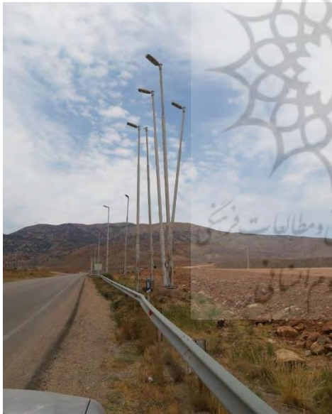
شکل ۱۴: خطر سقوط تیر چراغ برق
