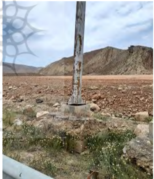
شکل ۱۴: خطر سقوط تیر چراغ برق
