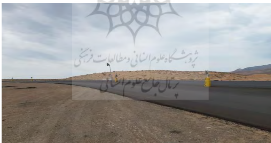
شکل ۱۲: ترمیم روسازی محور شاهرود - آزادشهر
