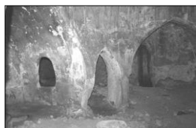
ت ۱۸. بخش الحاقات در جبهه شرقی گرمخانه حمام صخره‌ای کهنمو
