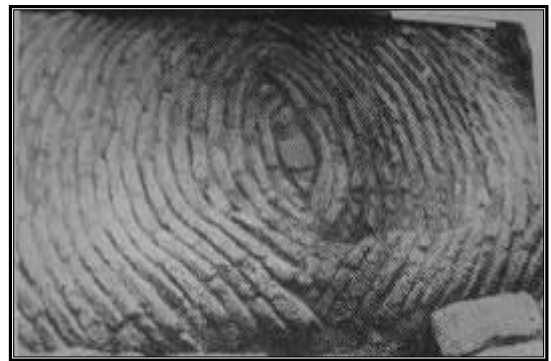
ت ۷. یکی از کهن ترین نمونه های تاق لی لی پوش. تل الرماح در عراق، (منبع: بزנוال، ۱۳۷۹: ۱۰۸).
