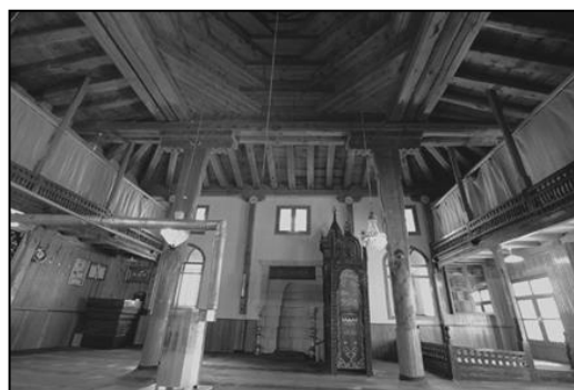
ت ۹. ساخت سقف چوبی مسجد Konursu Ulu ترکیه به روش Kurlangıç Örtü.
