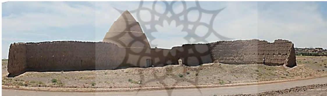
ت 5. دیوارهای اصلی و جانبی سایه‌انداز و وضعیت امروزی حوضچه‌های یخ‌ساز در نمای شمالی یخچال بافران. (منبع: نگارندگان).
