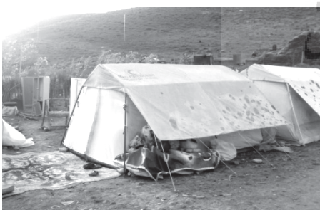
ت ۵. روکش نایلونی روی چادرها برای جلوگیری از ورود باران.
