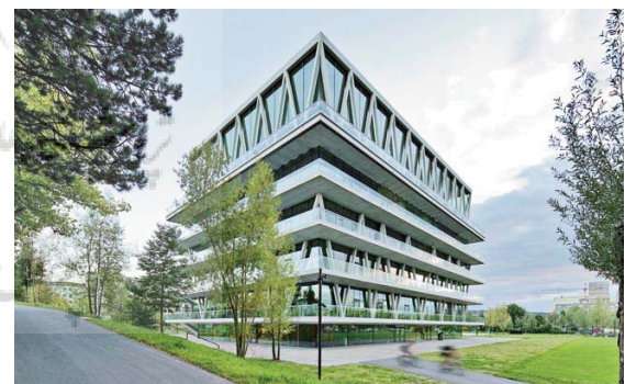
ت ۵. بالا : مجتمع مسکونی WaldSpirale در آلمان. پایین: مدرسه The-Leutschenbach در زوریخ نمونه‌هایی از بناهایی که با استفاده از سنگدانه‌های بازیافتی در بتن ساخته شده‌اند.
