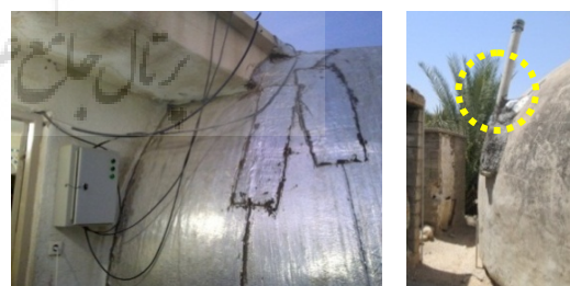
ت۱۶. راه‌حل‌های ابتکاری ساکنین برای سازگار نمودن اتصالات خطوط برق، کولر و دودکش‌ها. منبع: نگارنده.
