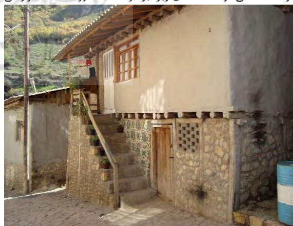
تصویر شماره (۷): جزئیات استفاده از سنگ در نمونه های مسکن بومی روستایی مورد مطالعه
