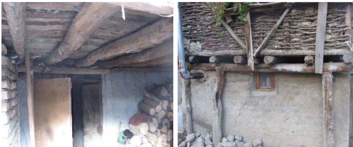
تصویر شماره (۸): جزئیات استفاده از چوب در تیرهای سقف در نمونه های مسکن بومی روستایی مورد مطالعه
