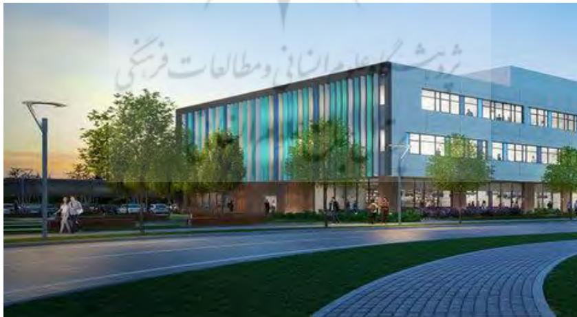
شکل ۱۱- ساختمان "evolve1" (ماخذ: http://www.energyenergy.ir )
