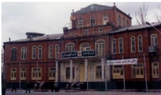
شکل ۷ - ساختمان ستاد ارتش ارومیه (ماخذ: میراث فرهنگی ارومیه)
